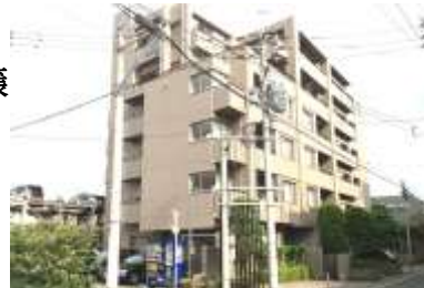
平成16年新築のマンションです
