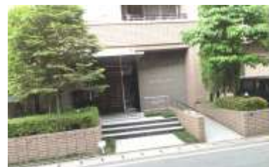
エントランス なんとなくセレクト♪
