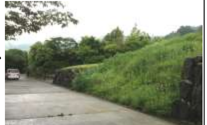
北側乗り入れ部分。道路幅は十分です。
